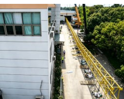
起重钢结构吊梁静载荷试验
