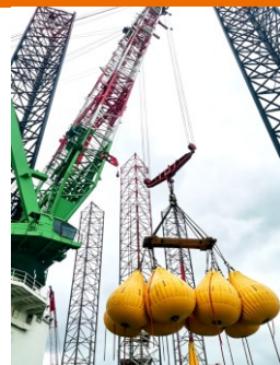
超大吨位起重吊梁水袋静载测试 (可测试单梁 WLL1500t)
