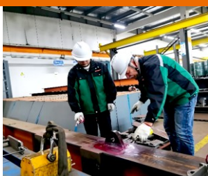
PT检测吊梁
